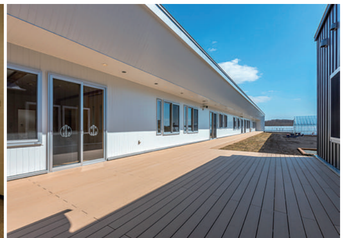
安全面と耐久性に配慮したデッキテラス
